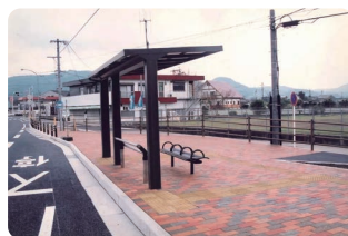
道路舗装工事
