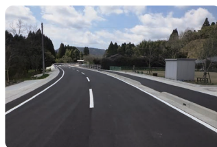
道路改良工事
